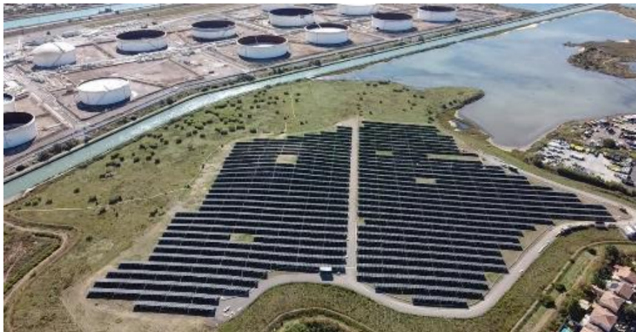
Frontignan (34) – 5MWc Réhabilitation d'une ancienne décharge
